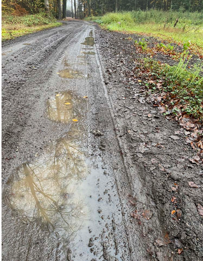
Skader på vejen efter roekørsel med lastbiler.
