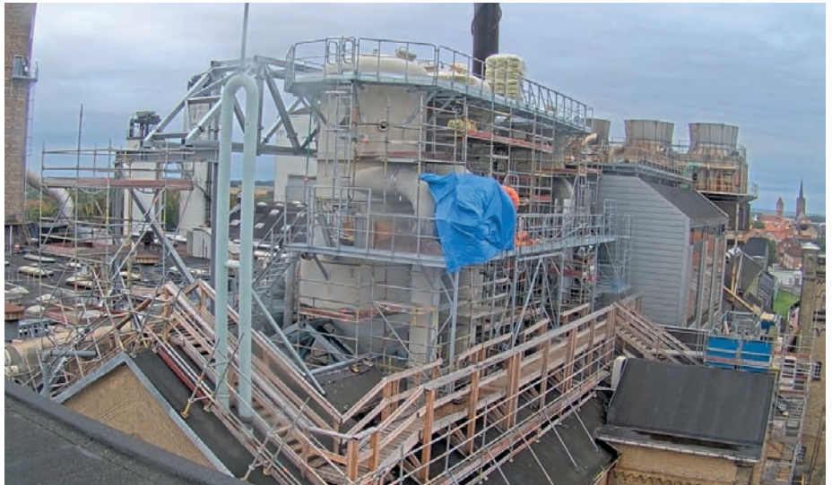
Udskiftning af fordamperapparater i Nakskov. I alt investeres ca. 110 mio. kr i Nakskov i 2023.
