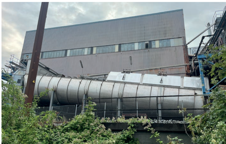
I Nykøbing er der i 2023 bl.a. foretaget en renovering af diffusionstrug 1, som har fået en ny rustfri bund og top. I alt investeres 190 mio. kr i Nykøbing i 2023.
