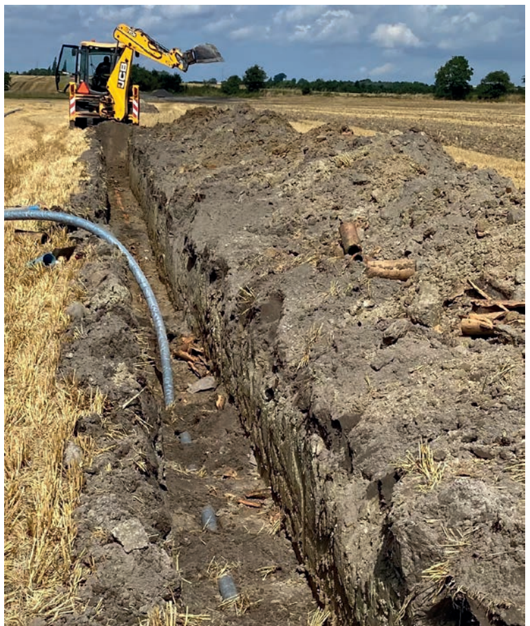
Vedligeholdelsen af drænen har stor betydning. Her skifter vi et hoveddræn, hvor der skal være roer næste år.
