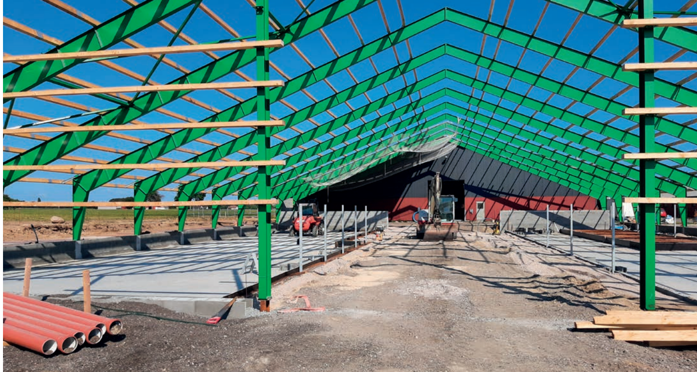
Nyt staldbyggeri til goldkøer, kælvbokse og dybstrøelsesareal til alle kalve fra 0-12 mdr.
