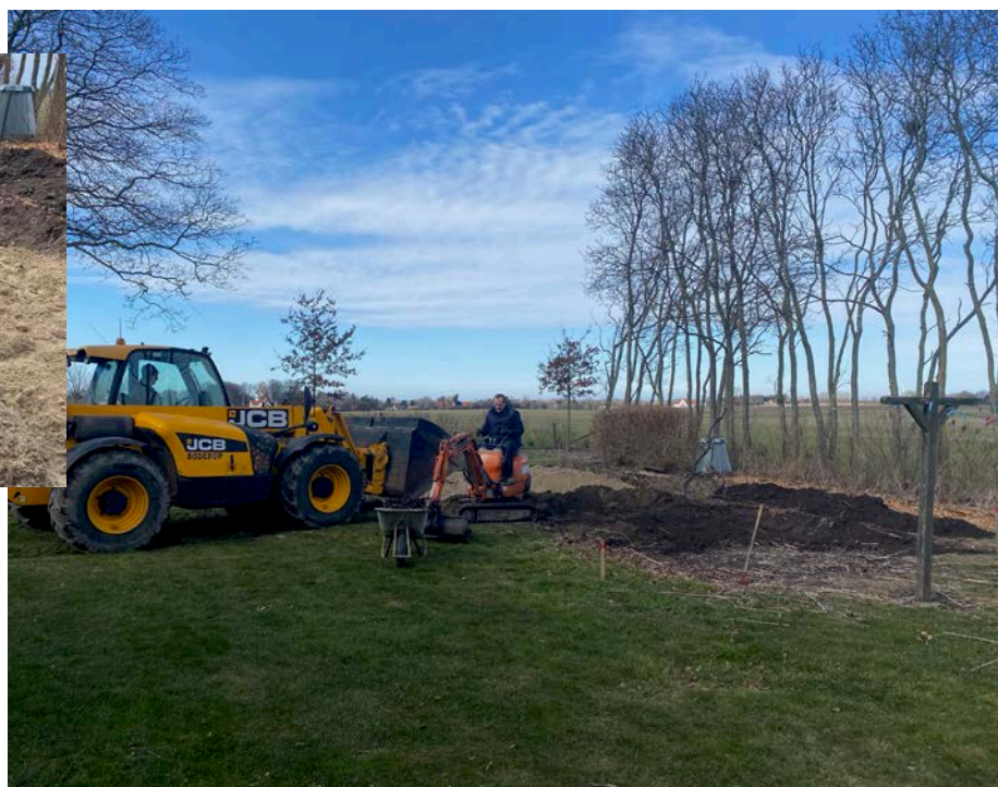
Der gøres klar til opsætning af det nye drivhus.
