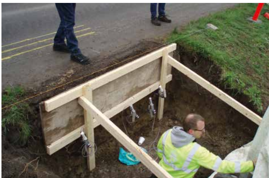
Der måles bl.a. trykpåvirkningen i dybden under vejen vha. censorer, der er ført ind under vejbanen.
