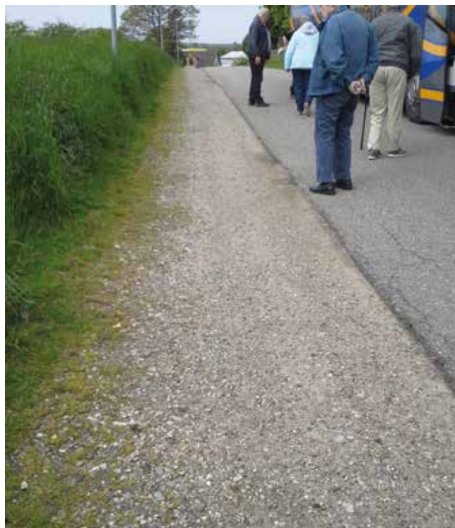
Et eksempel på en god fundering af en vejrabat, som derved kan tåle kørsel.
