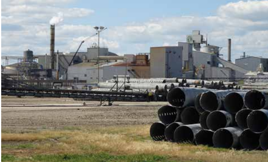
Minn-Dak Farmers sukkerfabrik i Wahpeton, North Dakota. I forgrunden ses de perforerede rør, som bruges til at nedkøle og senere fryse roedepoterne.
