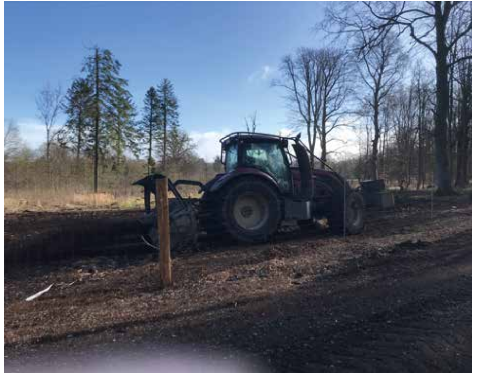
Entreprenør med grenknuser i gang i Parken.
