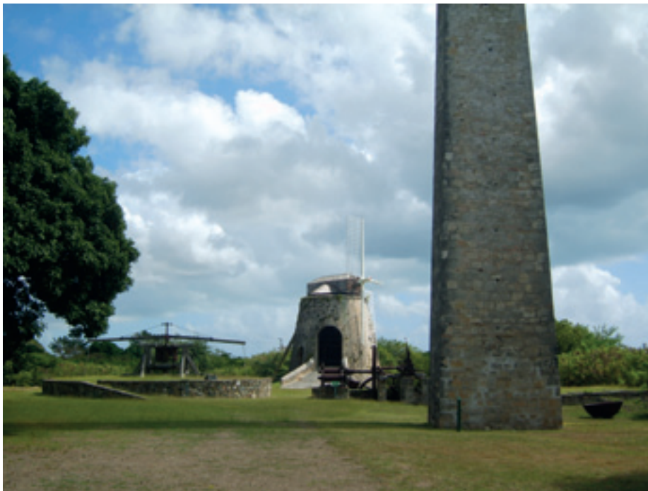
På billedet ses resterne af 3 forskellige typer af sukkermøller. Til venstre en hestetrakket mølle, til højre ses resterne af en damptrukket mølle med skorstenen i forgrunden og bagerst ses en "rigtig" vinddreven sukkermølle, som var den dominerende form.
