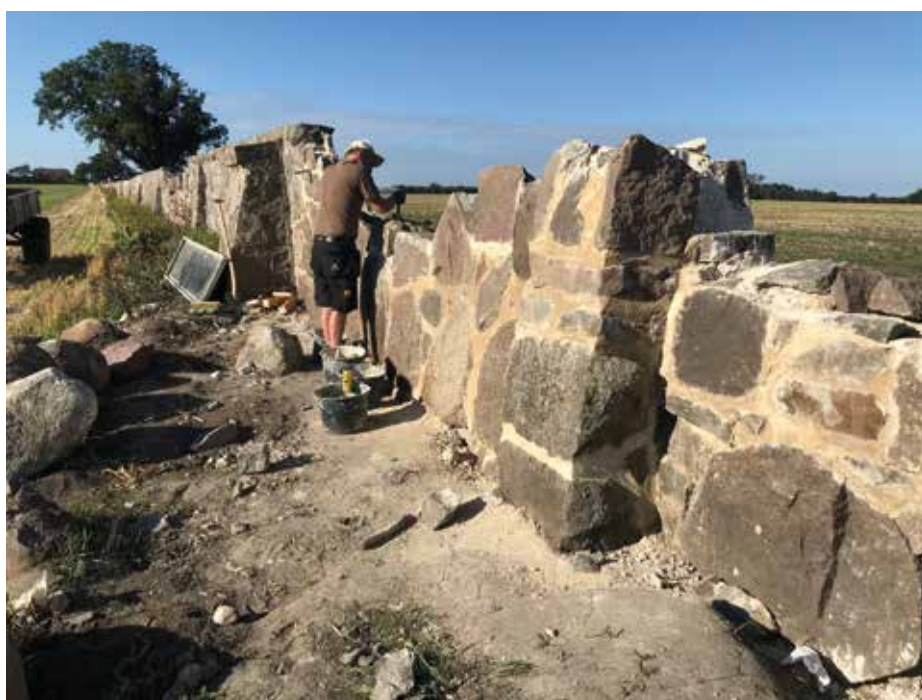
Renovering af den 7 kilometer lange Parkmur er fast arbejde.
