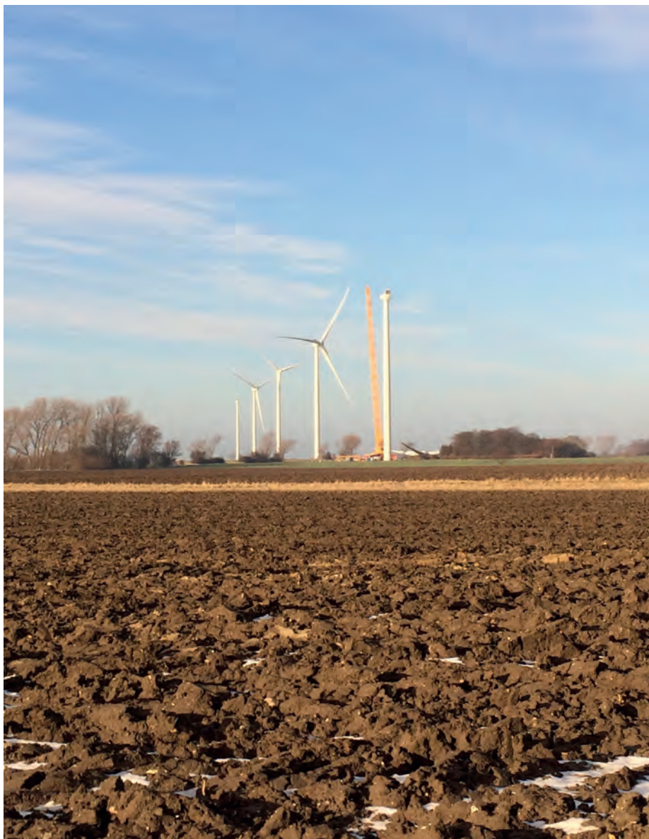
Opsætning af vindmøllepark i Tjørneby med 5 stk. 3 megawatt møller.
